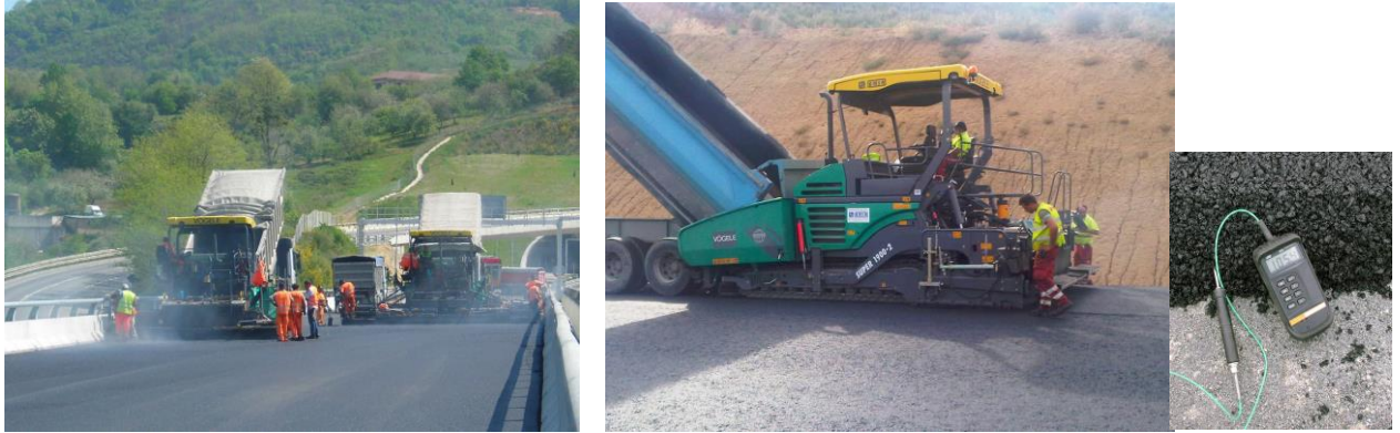
Diferentes condiciones de trabajo entre una mezcla tradicional y una con espuma de betún.
